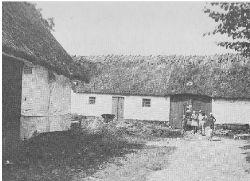
Indkørsel til Vesterager fra bygaden fra øst. tv. møddingen.
